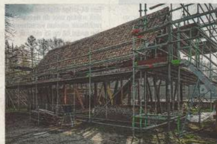
Postje Loppem, de rieten dakbedekking van het woonhuis werd gedemonteerd, zodat het houtonderzoek van de gebinten kon plaatsvinden. FOTO LUC DAELMANS.
