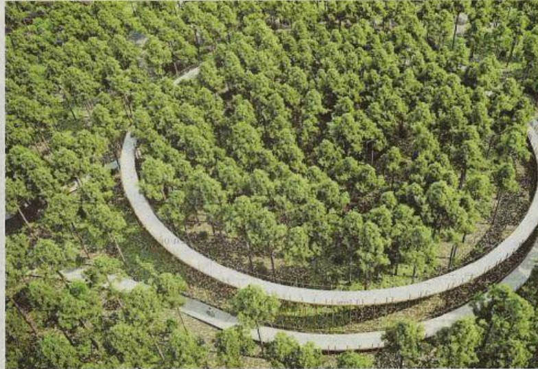
De stalen fietsbrug van 700 meter lang stijgt geleidelijk tot 10 meter hoogte. Repro Mine Dalemans
