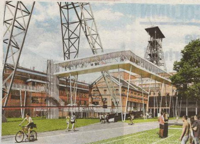
Vlaanderen steunt de uitbouw van het mijnbelevingscentrum. FOTO HAVL
