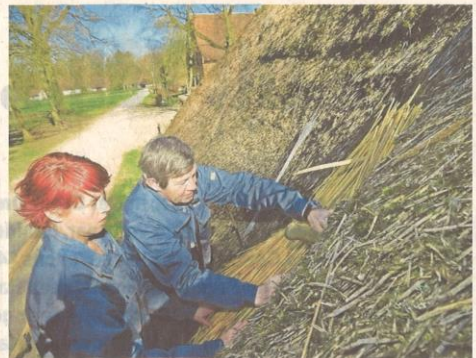
Jos leert Aïcha hoe ze het rieten dak moet herstellen.
